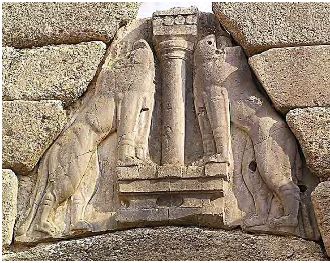
Разгрузочная система Львиных ворот
