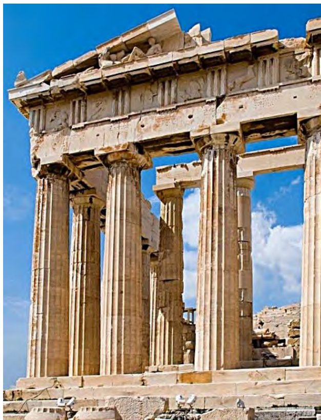
На колоннах лежат несущие балки – архитравы
