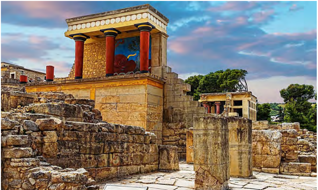
Трёхслойные стены дворца и кладка из крупных камней
