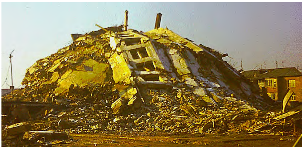
Двадцатипятиэтажное здание, рассыпавшееся при Армянском землетрясении 1988 года.
