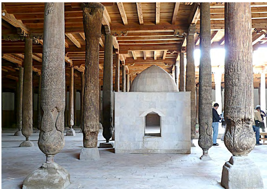
Видно устройство деревянных колонн в Джума-мечети
