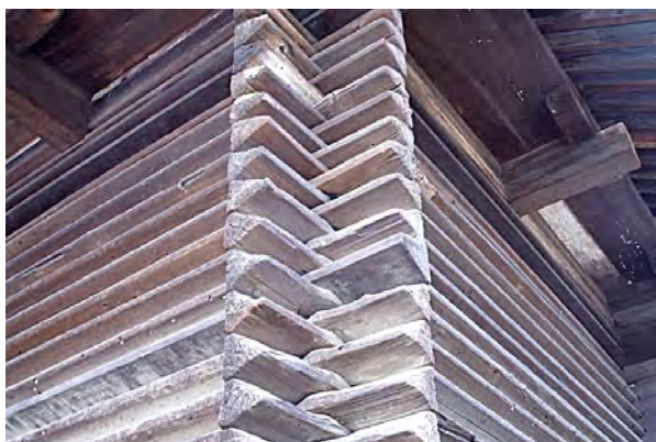
Сокровищница Сёсоин и фрагмент сруба её стен
