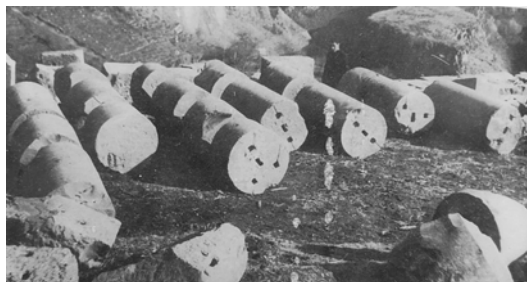
Видны отверстия в барабанах и основаниях колонн, сделанные перед сборкой.
