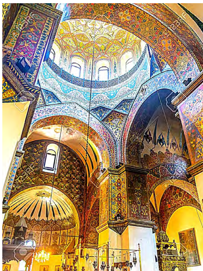
Центрическое крестовокупольное перекрытие Эчмиадзинского собора
