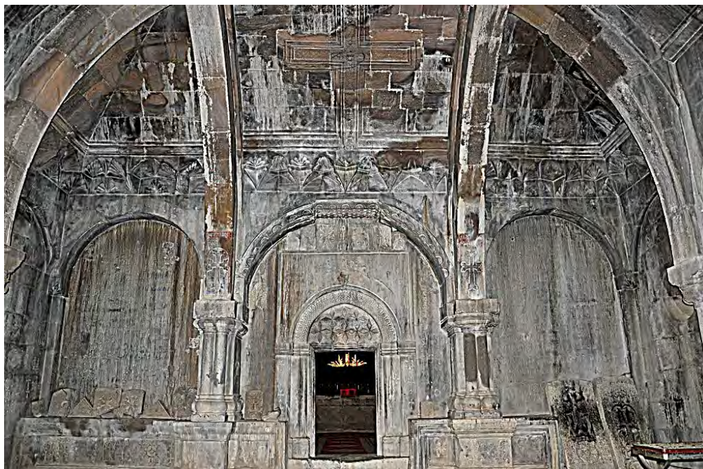
Видны парные арки перекрытия притвора и вход в церковь
