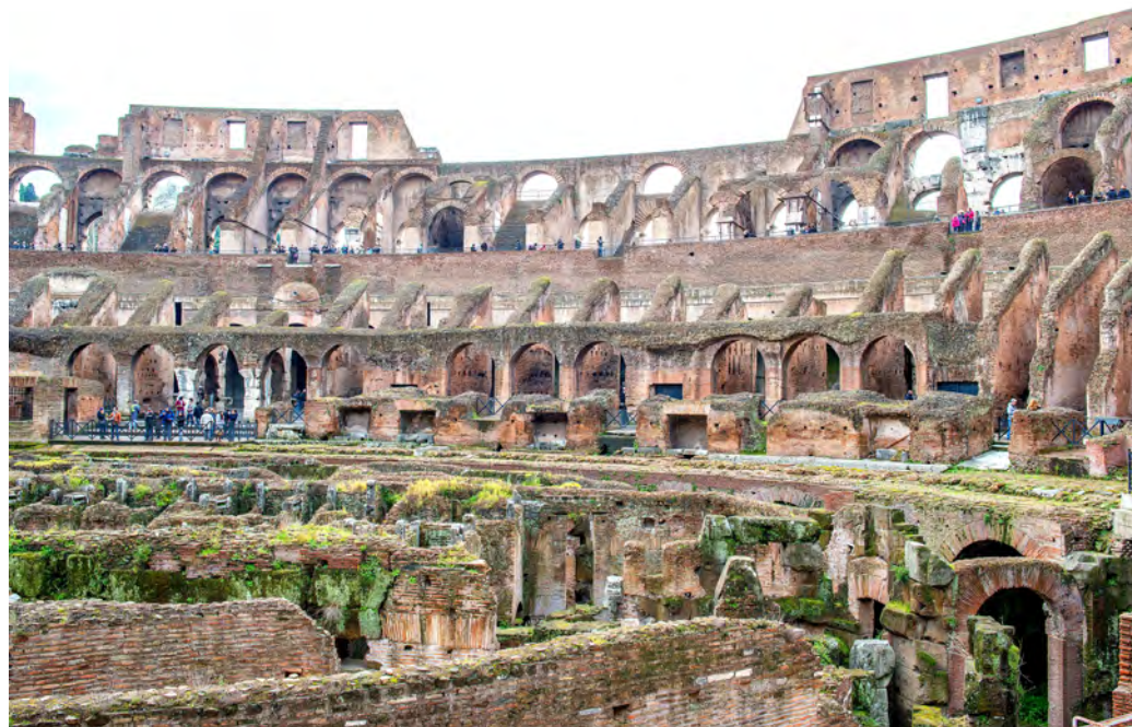
Облицовка внешней стены и несущие конструкции трибун.
