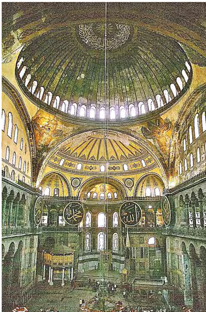
Видно, как центральный купол в продольном направлении опирается на полукупол, а в поперечном – на продольные стены.
