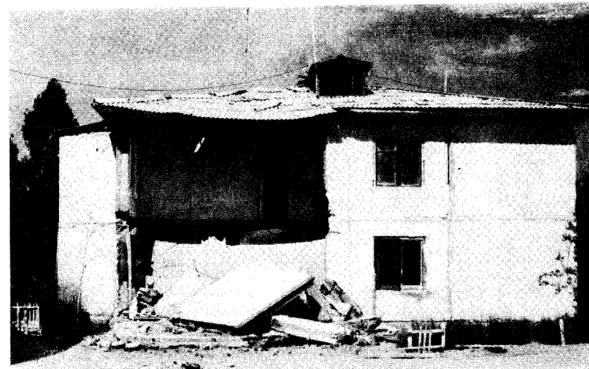
Рис. 11. 18. Обрушение торца дома, не имевшего цокольного перекрытия и связей в остальных перекрытиях
