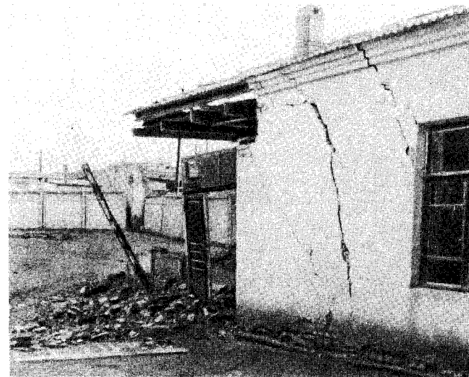
Рис. 11. 8. Обрушение торцовой стены и перекрытия одноэтажного строения из сырцового кирпича
