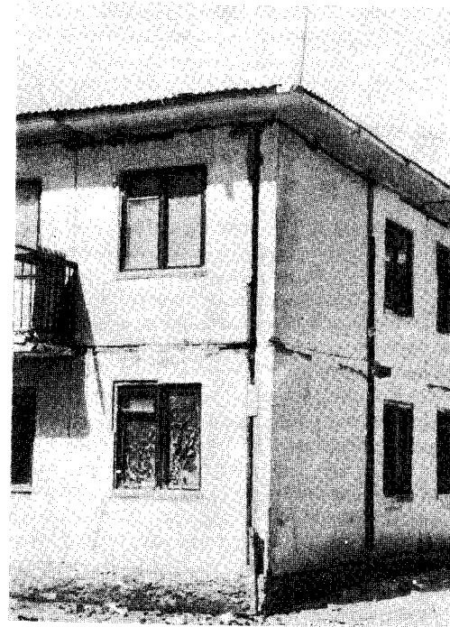
Рис. II. 20. Повреждение наружных стен дома
