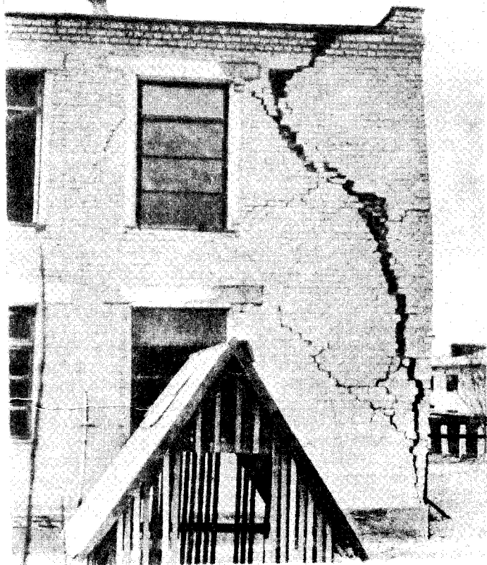
Рис. 1. 1. Отрыв продольных стен от поперечных в здании детсада (после землетрясения 8 апреля)
