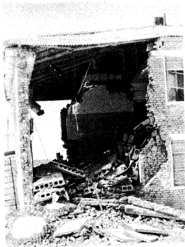
Рис. 11. 6. Разрушение конструкций дома быта
