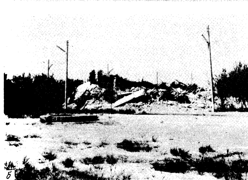
Рис. 1. 5. Общий вид здания больницы после землетрясений а — 8 апреля; б — 17 мая
