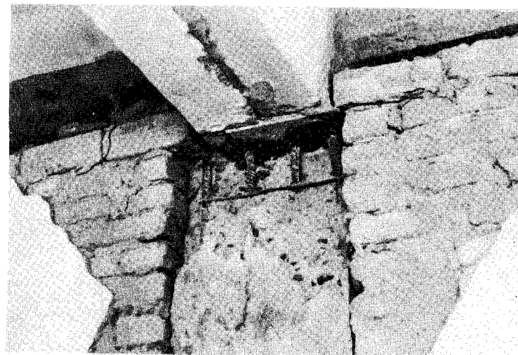
Рис. II. 29. Разрушение верха колонн в Доме техники после землетрясения 8 апреля
