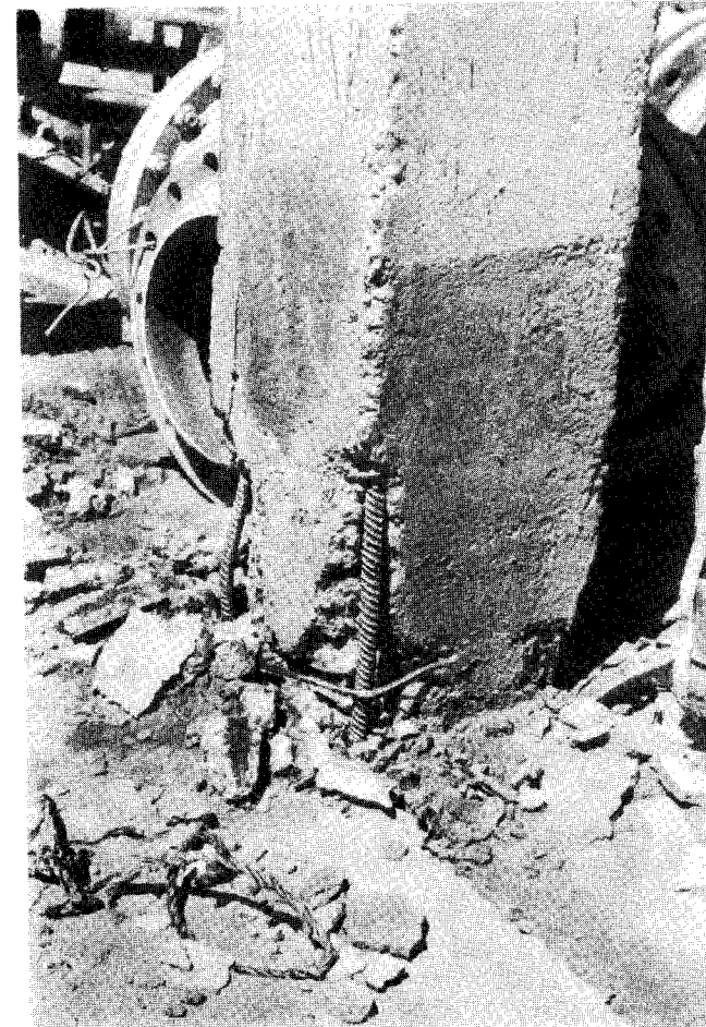
Рис. 1. 8. Повреждения колонн склада Газлийского нефтепромыслового управления (ГНПУ) после землетрясения 17 мая
