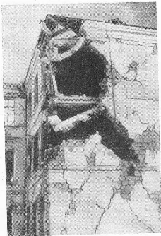
Рис. 90. Разрушение угла здания
