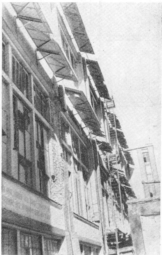
Рис. 151. Повреждение облицовки на фасаде
