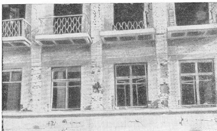
Рис. 111. Характер повреждения кирпичных пилястр облицовки. Железобетонные балконы сохранились хорошо
