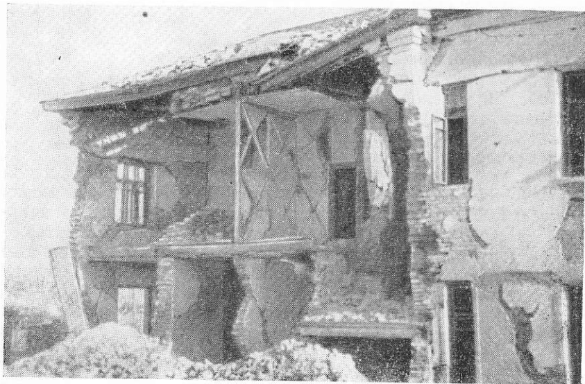
Рис. 32. Разрушение выступающей части стенки лестничной клетки и части фасадной стены
