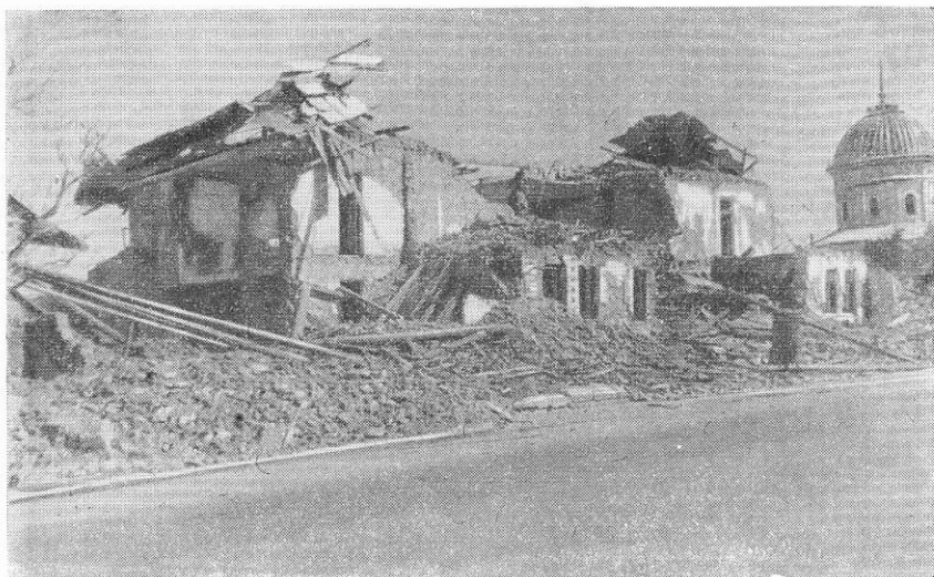
Рис. 119. Разрушения здания республиканского Управления милиции
