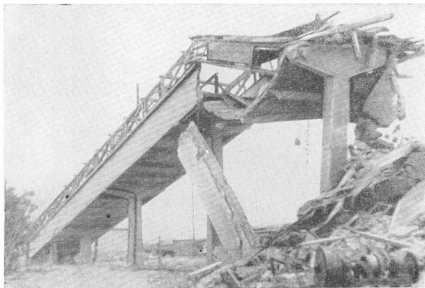
Рис. 175. Разрушение железобетонных стоек и перекрытия взгона
