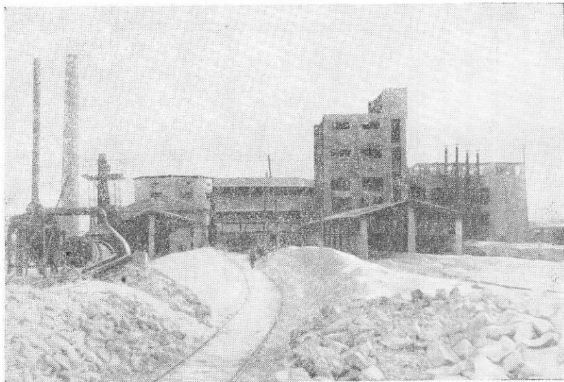
Рис. 132. Механический стекольный завод после землетрясения
