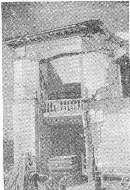
Рис. 63. Повреждение угловых лоджий и срез боковых пилонов
