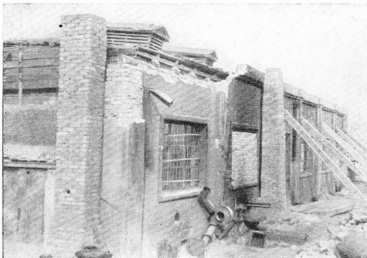
Рис. 179. В здании столовой разрушены кирпичные парапеты, а продольная стена отошла от своей вертикали
