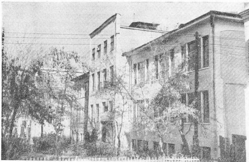
Рис. 248. Административное здание сейсмостойкой конструкции с железобетонным каркасом и фибролитовым заполнением
