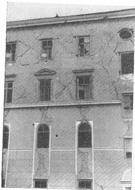
Рис. 99. Косые трещины в простенках между оконными проемами со стороны дворового фасада
