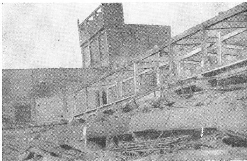
Рис. 133. Повреждение железобетонных рам
