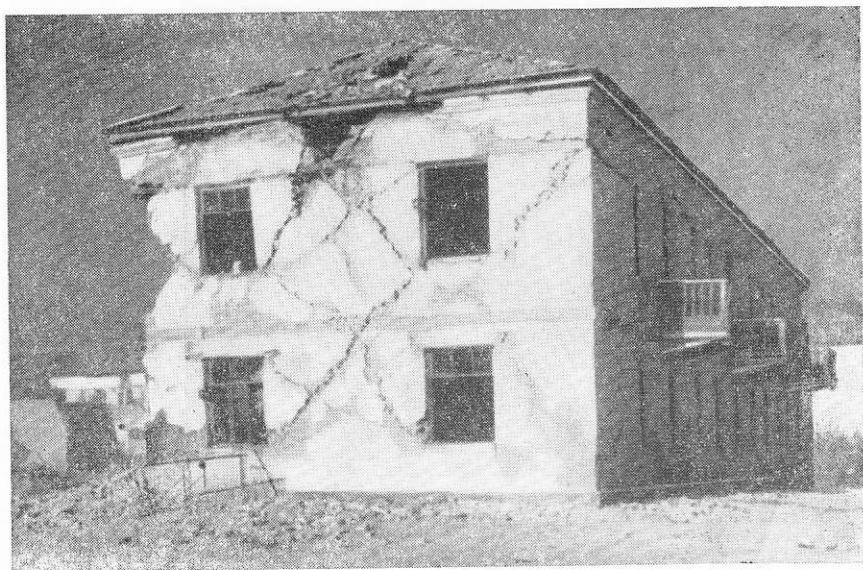
Рис. 34. Разрушение торцевой стены с широким простенком в месте примыкания к внутренней продольной стене
