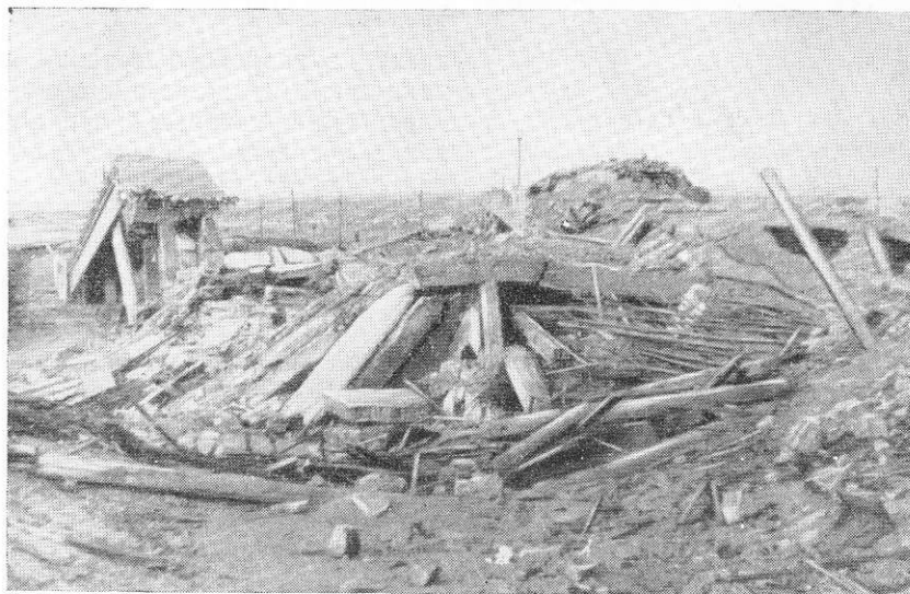
Рис. 173. Разрушения мясокомбината со стороны взгона
