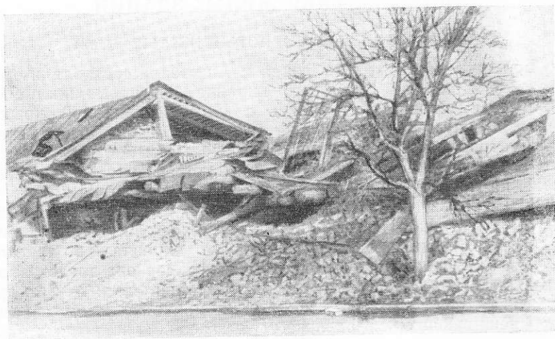
Рис. 18. Дом во дворе главного почтамта из сырцового кирпича полностью разрушился
