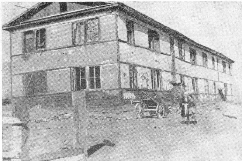
Рис. 197. Хорошо сохранившийся 2-этажный деревянный каркасный дом ашхабадского горводопровода
