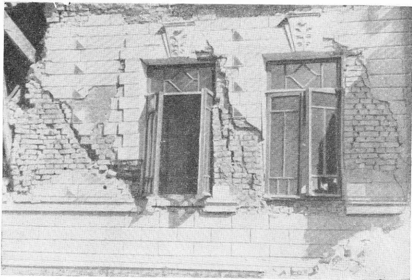
Рис. 121 Разрушение простенков
