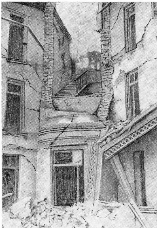
Рис. 41. Разрушение стены полукруглой лестничной клетки выходящей во двор (план дома на рис. 36)
