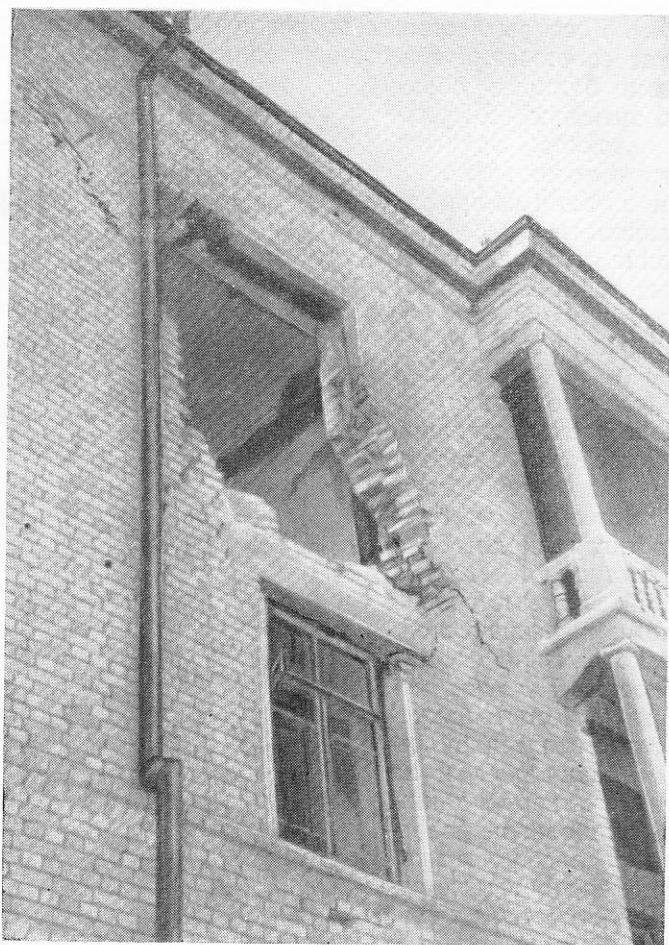
Рис. 51. Обрушение железобетонного балкона
