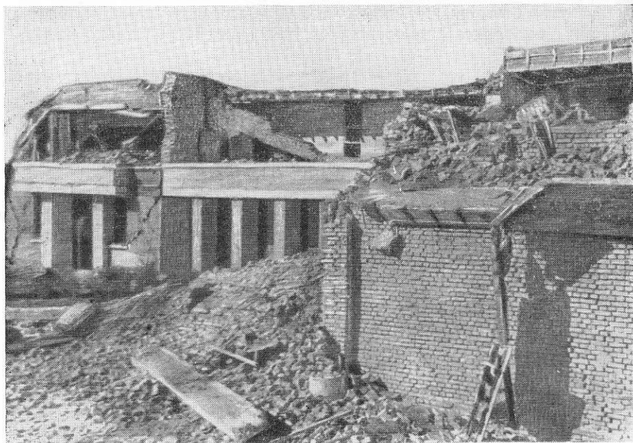
Рис. 104. Разрушения здания клуба
