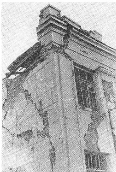
Рис. 217. Разрушение карнизов и парапетов
