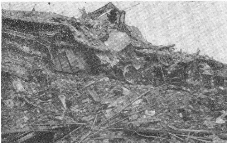
Рис. 170. Разрушенное здание холодильника
