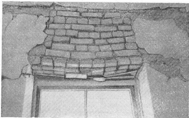
Рис. 43. Характер повреждения рядовой кирпичной перемычки
