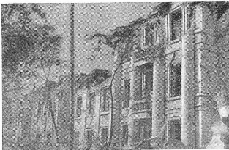
Рис. 228. Разрушение тяжелых парапетов
