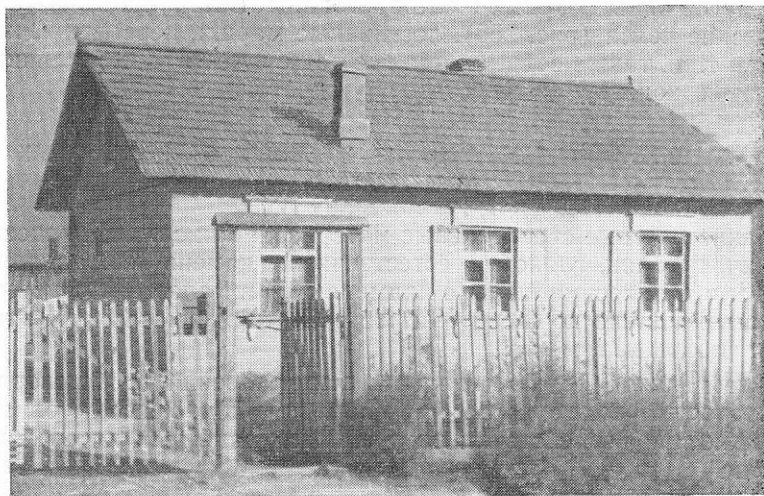
Рис. 256. Фасад одноквартирного дома каркасно-камышитовой конструкции, широко применяющейся при строительстве в высокосейсмических районах
