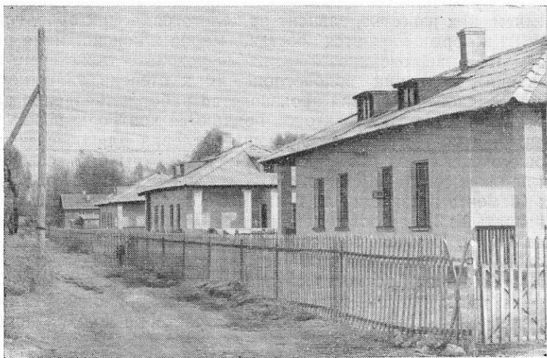
Рис. *258. Общий вид саманных жилых домов МТС (в 9-балльном сейсмическом районе)
