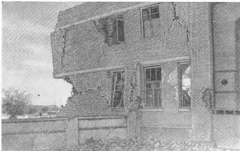
Рис. 103. Разрушение угла и простенков здания
