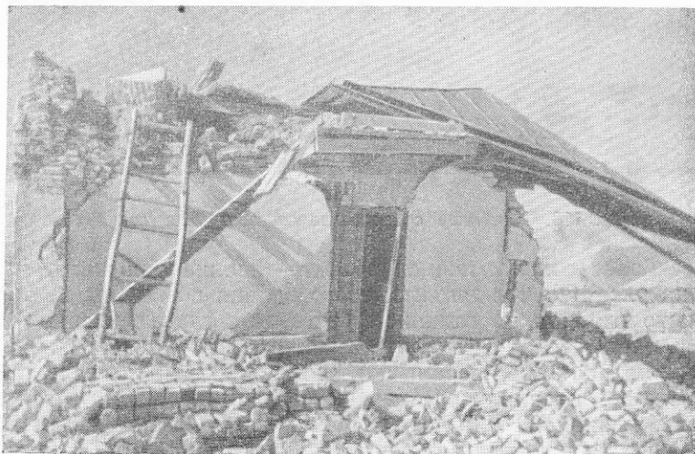
Рис. 187. Смещение крыши бани
