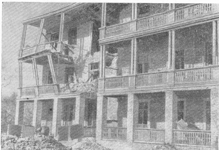
Рис. 52. Трехъярусные деревянные веранды с кирпичными стойками в 1-м этаже. Угловые части веранды разрушились
