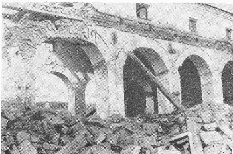
Рис. 181. Часть фасада табачной фабрики. Характер повреждения арок
