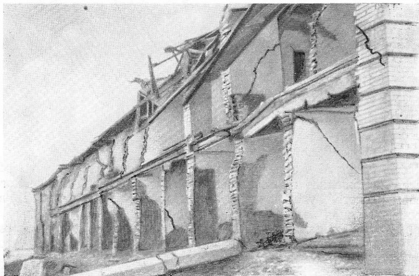
Рис. 26. Разрушенная продольная стена корпуса № 4 с северной стороны
