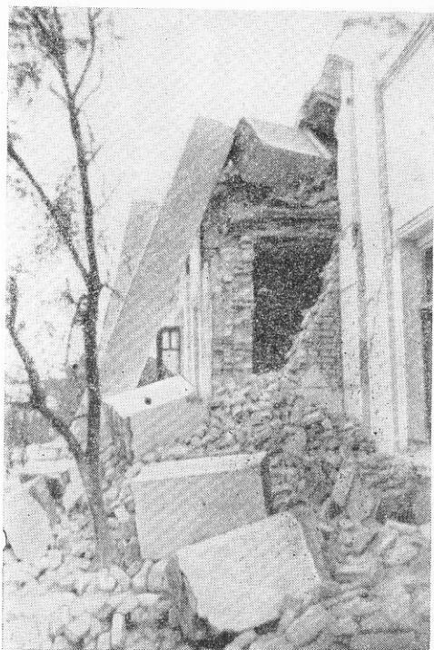
Рис. 234. Разрушение кирпичного портика школы
