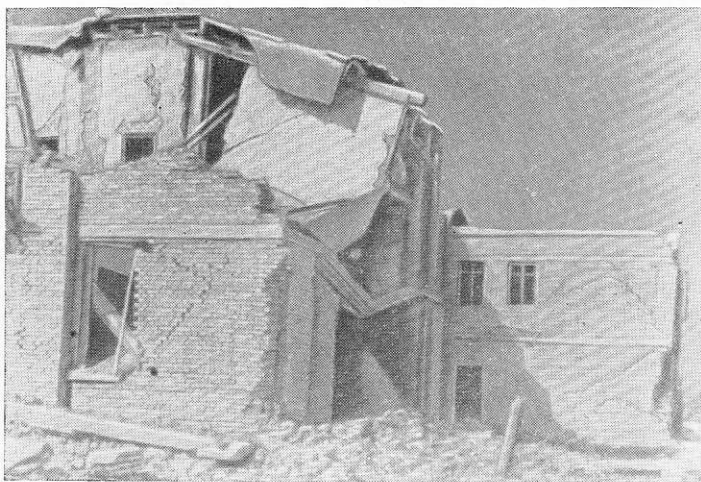
Рис. 101. Разрушение углов и стен верхнего этажа выступающих частей здания
