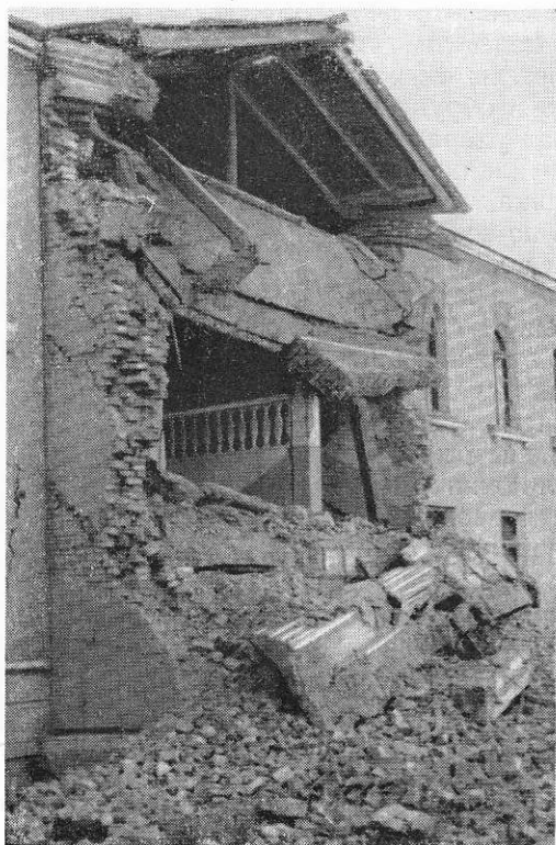
Рис. 64. Разрушение выступающей стены лестничной клетки
