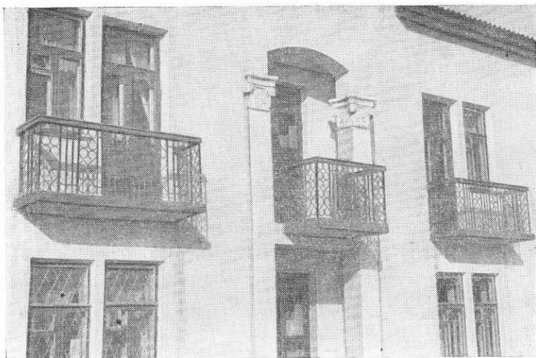
Рис. 243. Фрагмент фасада 8-квартирного жилого дома. Легкие сборные железобетонные балконы с небольшим выносом, применяемые в строительстве г. Алма-Аты
