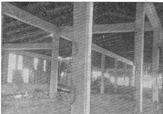
Рис. 159. Сохранившийся железобетонный каркас верхнего этажа
