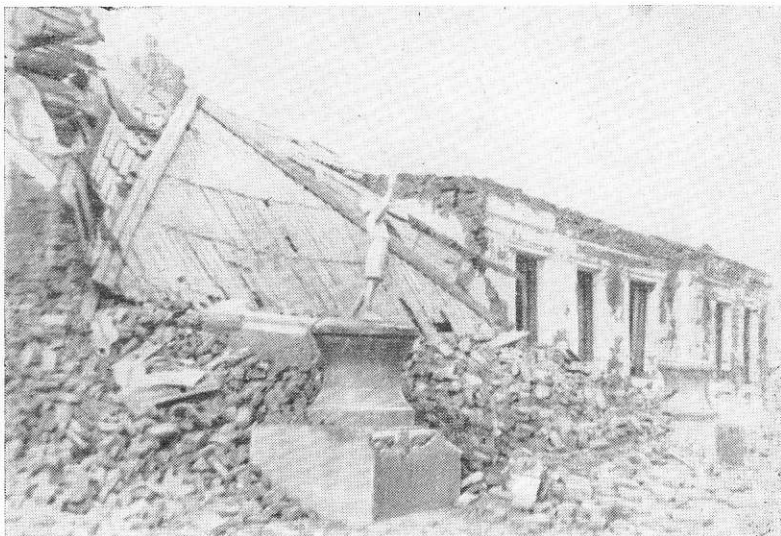
Рис. 215. Разрушенное здание детского дома со стороны главного фасада
