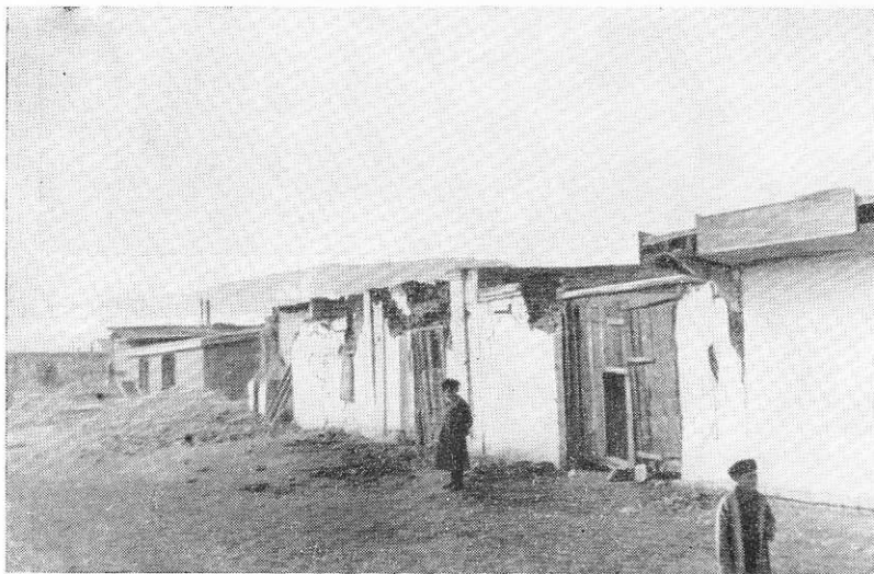
Рис. 207. Сырцовые жилые дома в поселке Безмеин после землетрясения
