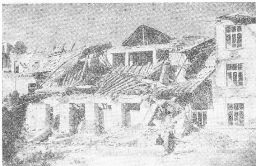
Рис. 233. Обрушение железобетонного портала с фронтоном высотой в 2 этажа в разрушенном здании Педагогического института
