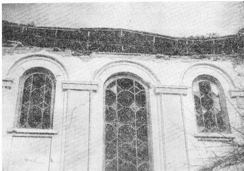
Рис. 232. При повреждении карнизной части стены арочные полуциркулярные перемычки хорошо сохранились
