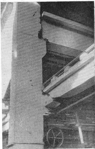
Рис. 156. Стык сборных элементов здания тепловозного депо разошелся
