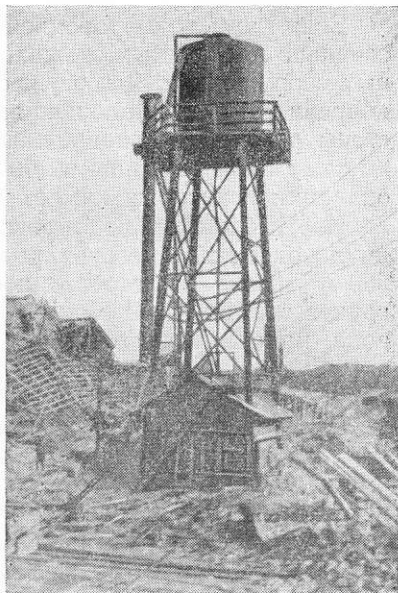
Рис. 226. Сохранившаяся водонапорная башня на четырех стойках из швеллеров
