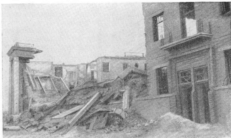
Рис. 109. Разрушения центрального отсека здания
