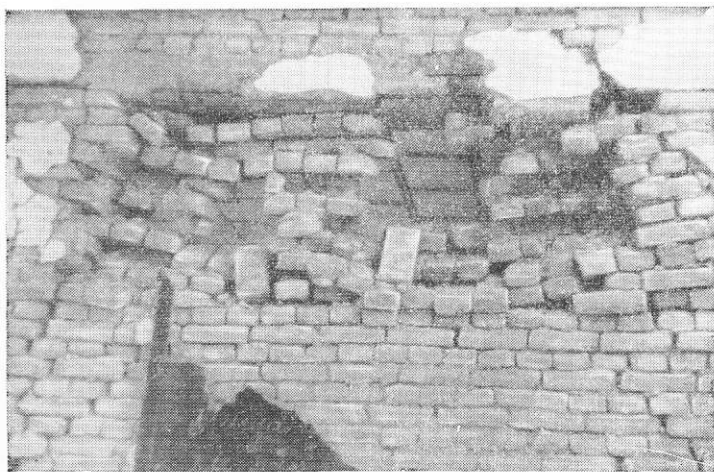
Рис. 218. Расслоение кирпичной кладки внутренней стены
