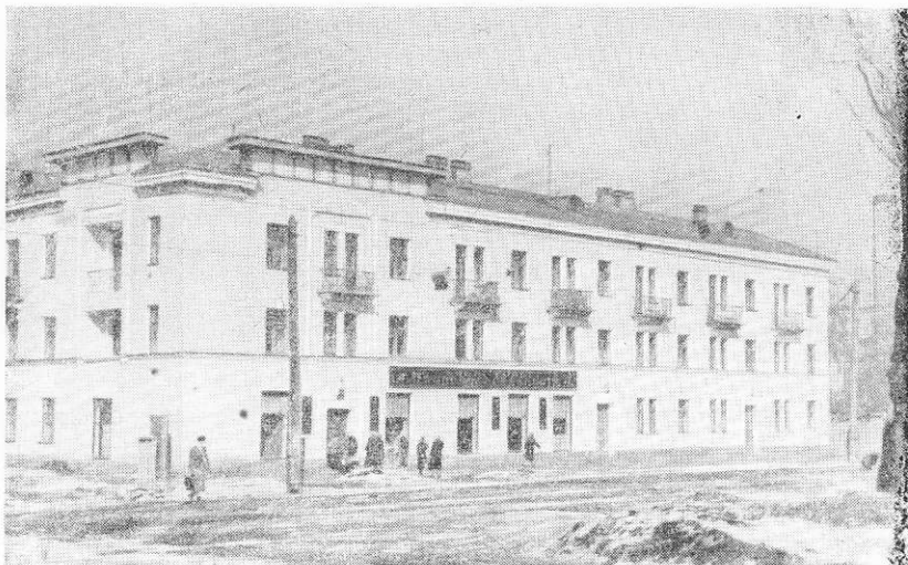
Рис. 246. Главный фасад 24-квартирного жилого дома ХОЗУ Совета Министров КазССР, построенный с учетом 9-балльной сейсмичности
