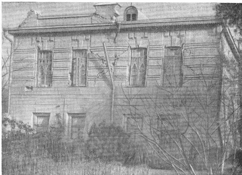
Рис. 125. Разрушение широких простенков в местах примыкания внутренних стен
