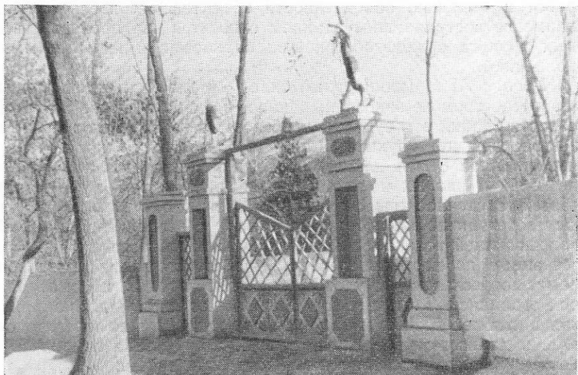
Рис. 201. Забор из сырцового кирпича в Фирюзе при 6-балльном землетрясении хорошо сохранился
