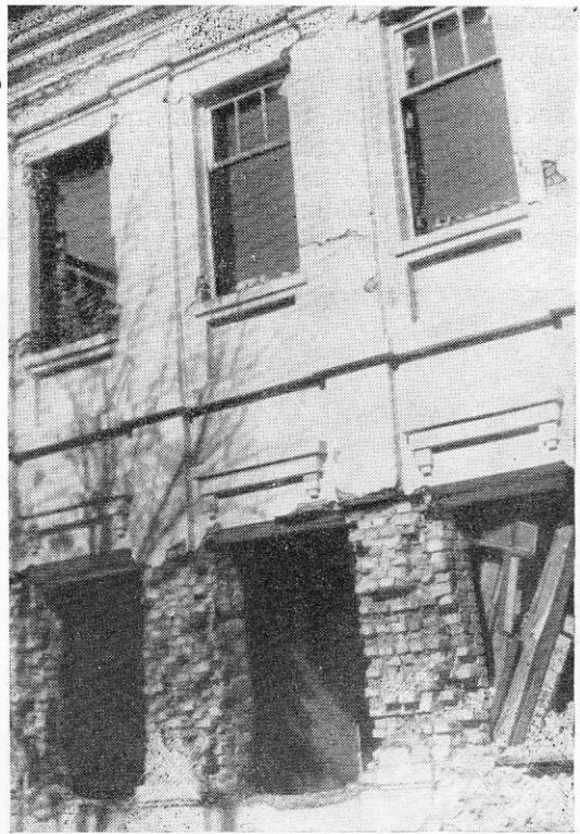
Рис. 3. Простенки в первом этаже разрушились от действия сжимающих усилий
