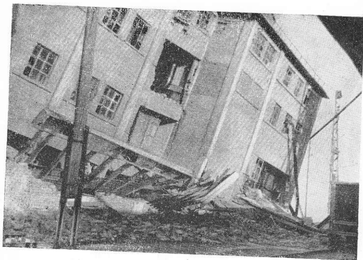
Рис. 143. Вследствие разрушения в 1-м этаже железобетонных стоек здание мельницы осело и дало крен на 30^\circ
