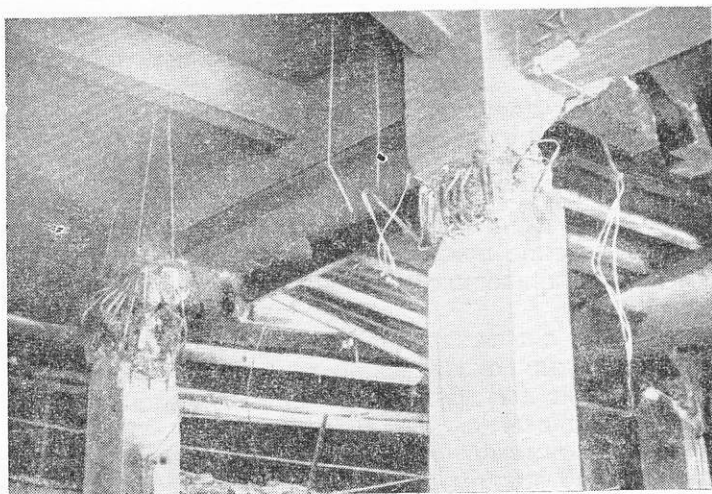
Рис. 235. Повреждение железобетонных стоек в местах их сопряжений с перекрытием
