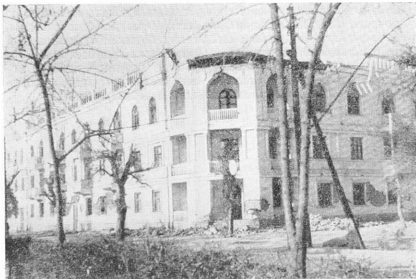
Рис. 238. Жилой дом № 12 по ул. Карла Маркса. Снаружи кажется слабо пострадавшим, но внутренние стены очень сильно повреждены
