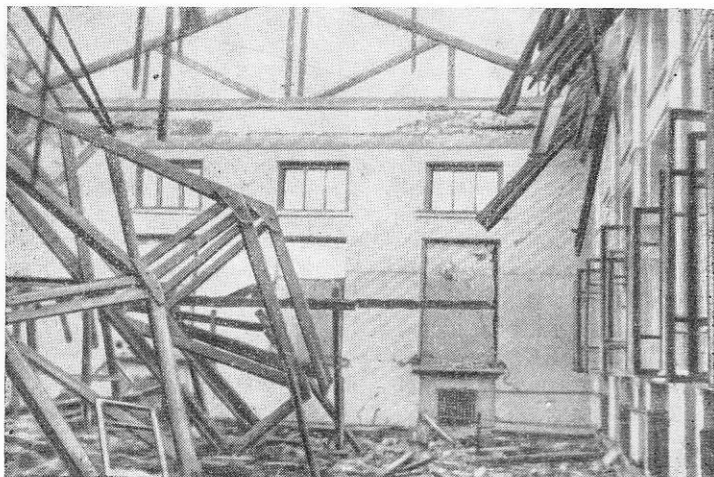
Рис. 70. Разрушенные деревянные дощатые фермы над актовым залом
