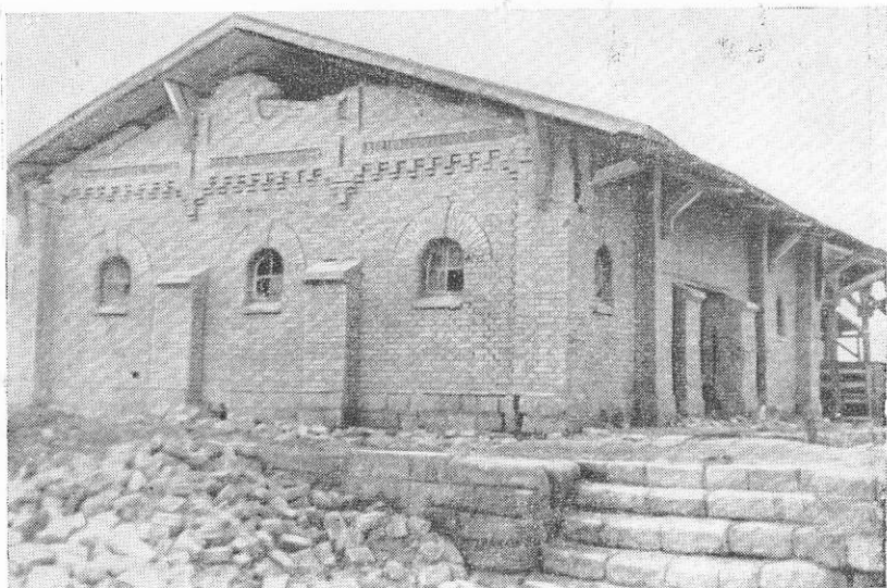
Рис. 210. Здание пакгауза после землетрясения
