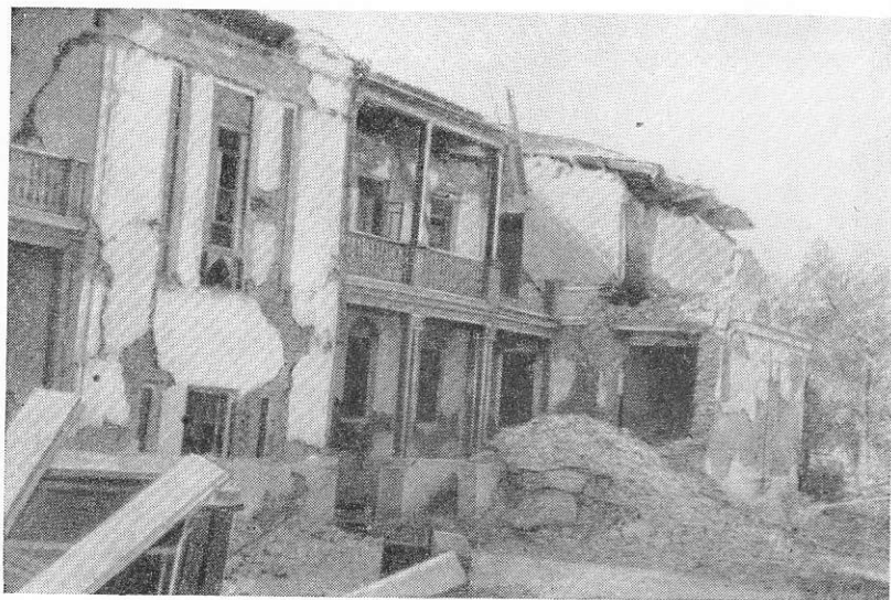
Рис. 120. Разрушение стен, выходящих во двор
