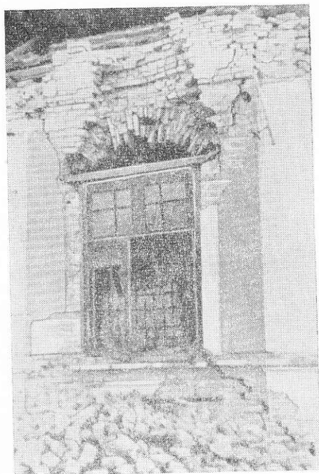
Рис. 236. Разрушение клинчатых перемычек
