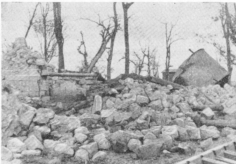
Рис. 212. Разрушение каменной водонапорной башни
