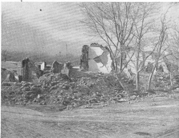
Рис. 213. Разрушения сырцовых домиков в поселке Геок-Тепе
