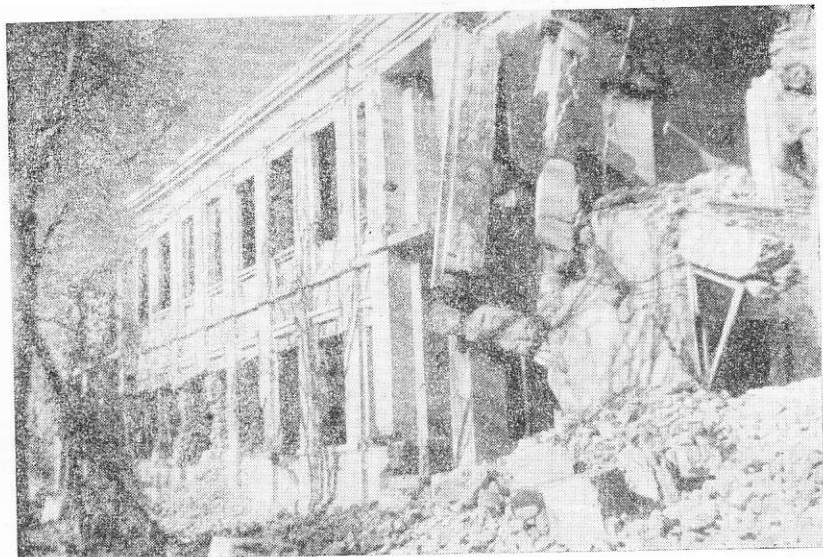
Рис. 230. Жилой дом горкомхоза на улице 1 Мая. Повреждений простенков в 1-м этаже больше, чем во 2-м
