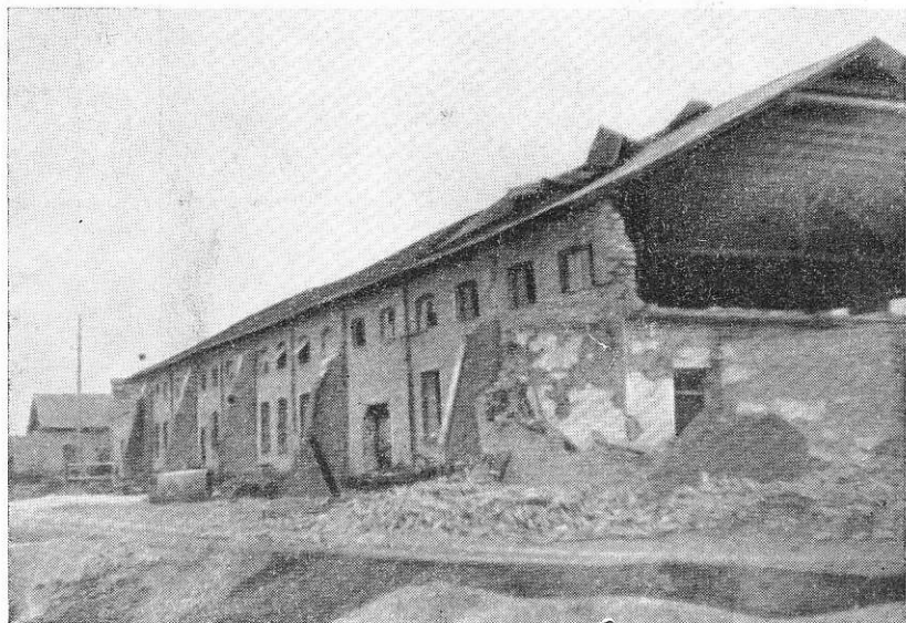
Рис. 163. Литейный цех после землетрясения
