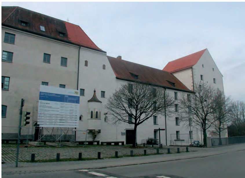
Современный вид герцогского замка - Herzogsschloss.
