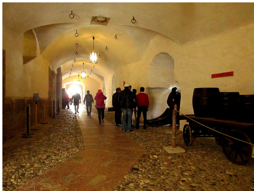
Туннель с цилиндрическим сводом сквозь здание Hohen Stock.
