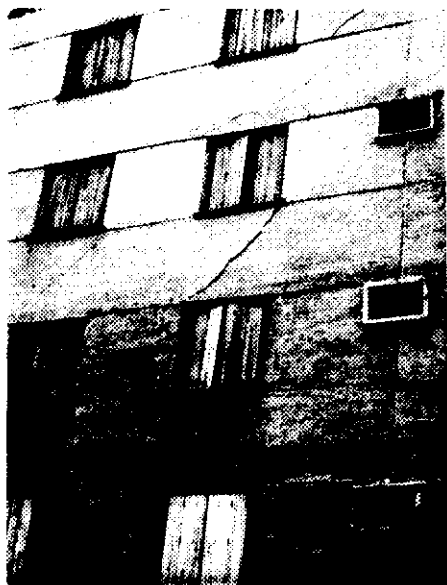
Рис. 17. Характер повреждения кирпичного здания соответствующей 3 степени. (в зоне 9-балльной сейсмичности.). Влияние просадки грунтов, а — трещины на фасаде, б — трещины внутри здания.
