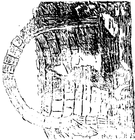
Рис. 48. Все перекрытие рухнуло, но арка продолжает держаться
