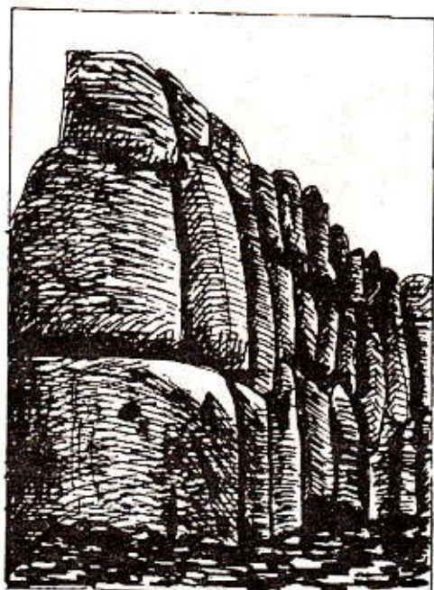
Рис. 121. Циклопическая кладка стены крепости инков
