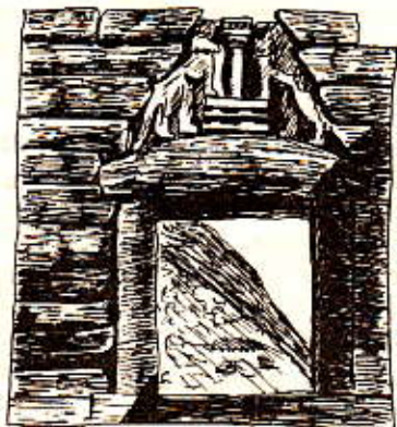
Рис. 10. Циклопическая кладка Древней Греции, Микены
