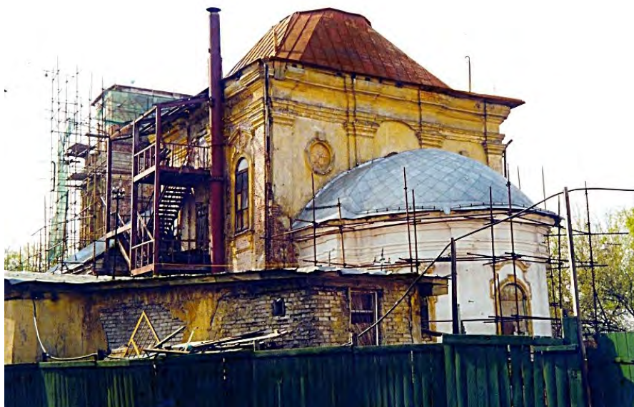
Самое начало XXI века. Начинаются восстановительные работы. Вокруг здания храма устанавливают первые строительные леса
