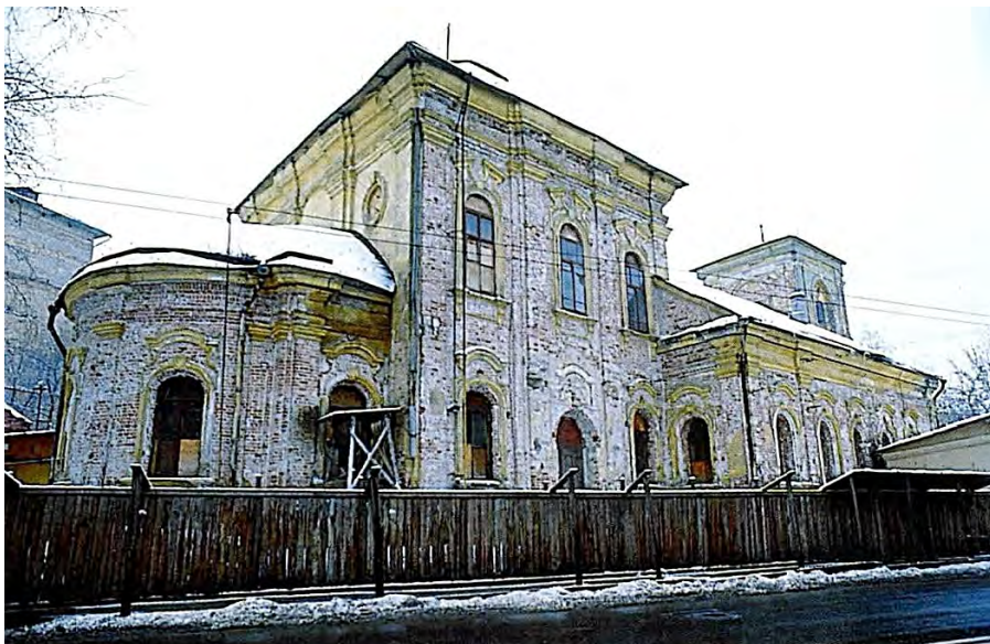
Кирпичная кладка храма очищена от старой штукатурки
