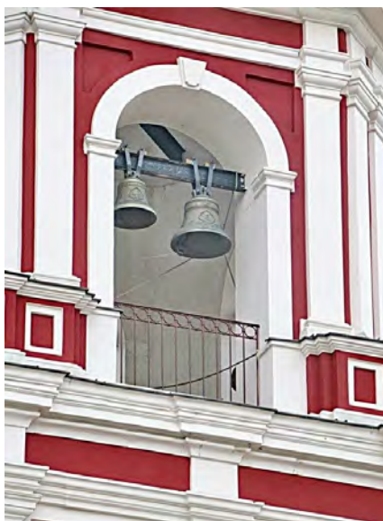
Слева – три яруса колокольни с восточной стороны. Справа – верхний ярус колокольни с той же стороны.
