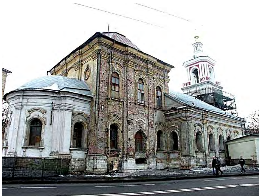
А вот уже возводится колокольня храма
